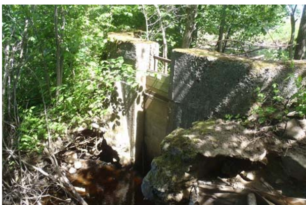
Foto 5.7 Vandringshinder vid äldre fiskdamm med raserat dämme (sträcka 61).
