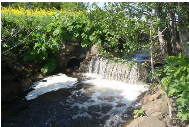
Foto 5.5 Partiellt vandringshinder uppströms kulvert (sträcka 46).
