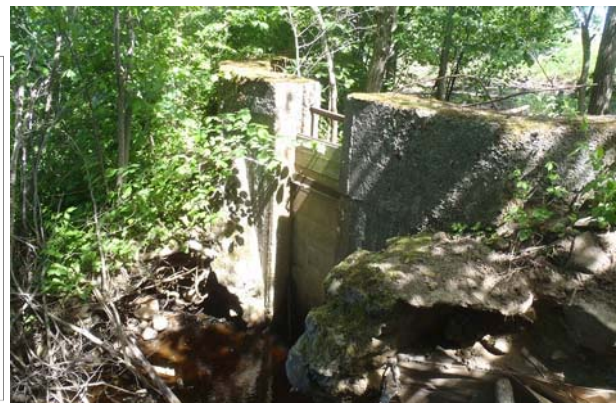
Sträcka 61, vandringshinder vid äldre fiskdamm
