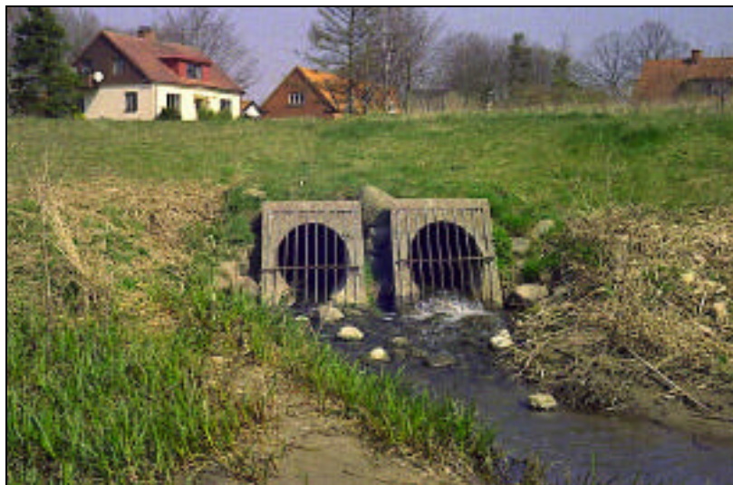
Utlopp i damm, belägen mellan sträcka 20 och 21 foto 7.
