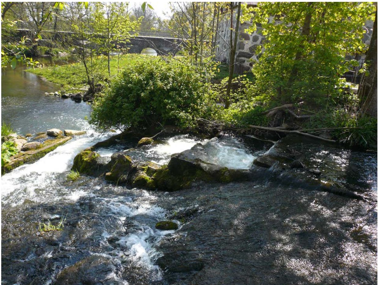
Äldre laxtrappa samt stenvalvsbo vid Svenstorps mölla.
