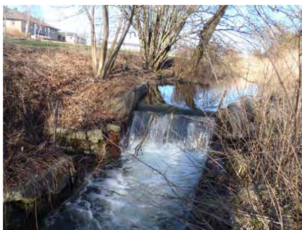
Foto 5.3 Utloppet från Våladammen utgörs av ett konstgjort dämme.
