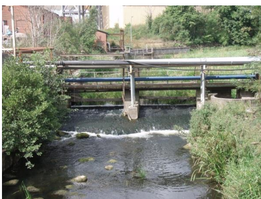
Figur 43. Vandringshinder nr 2 är ett dämme vid sockerbruket i Köpingebro. Foto: Karin Almlöf, Calluna AB.
