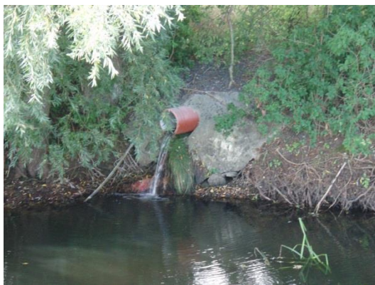
Figur 27. Avloppsrör vid vattendragssträcka 10 i Nybroån. Foto: Karin Almlöf, Calluna AB.
