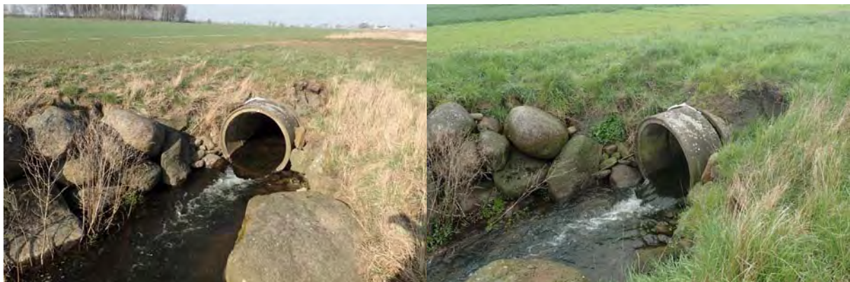
Kulvert nedströms övergång
