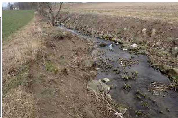
Sträcka 1, låg beskuggning och erosions kant
