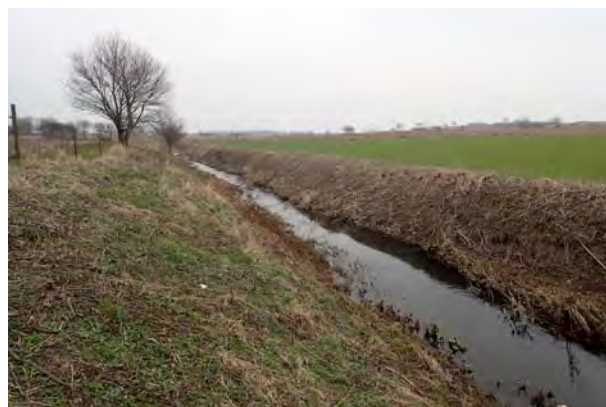
Sträcka 50, avfasning på norra sidan
