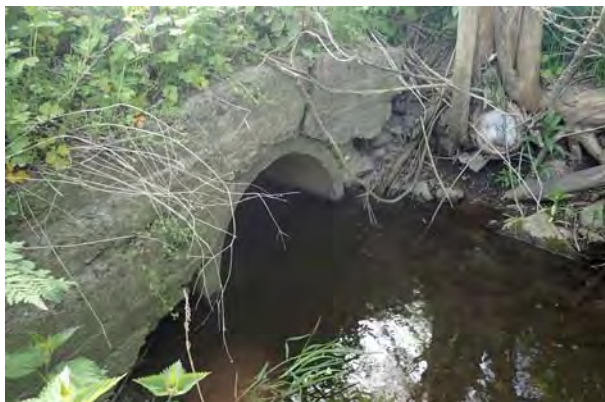
Utlopp från kulvert
