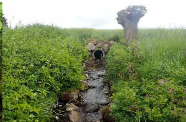
Sträcka 3, strömparti nedströms kulvert
