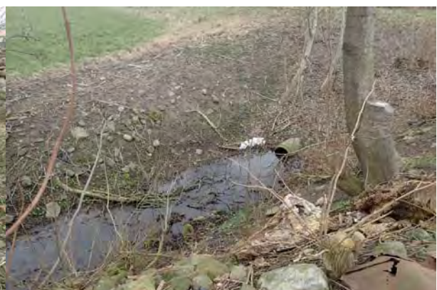
Sträcka 3, dikad sträcka nedströms landsväg
