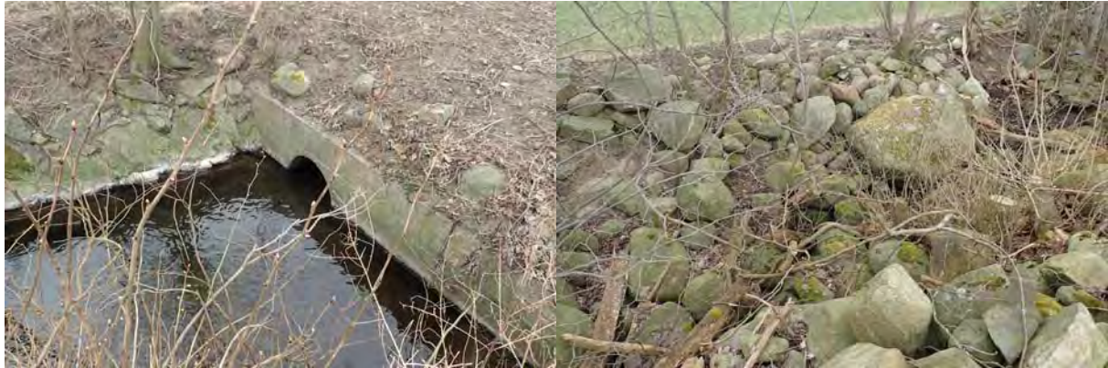
Fåran uppströms kulvert, igenfylld med stora block
