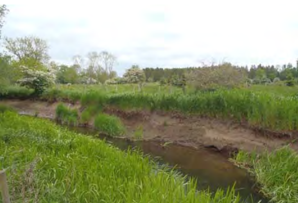
Sträcka 18, erosion längs strandbrinken
