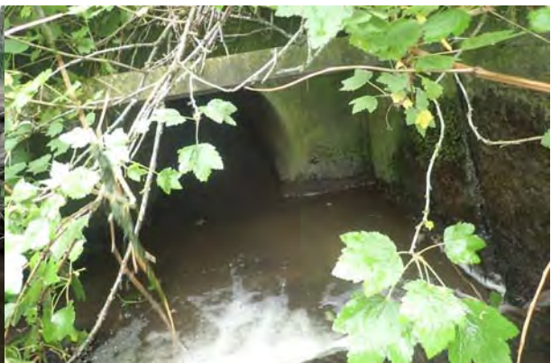
Ingång till kulvert
