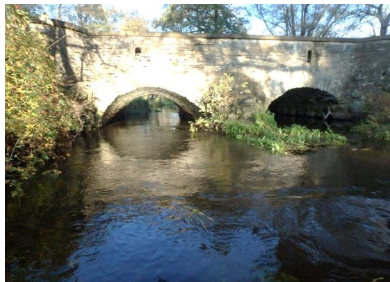
0-10 m nedströms stenbro.
