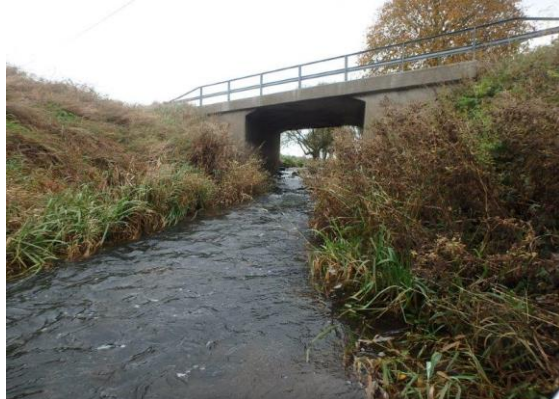
3-13 m nedströms vägbro.
